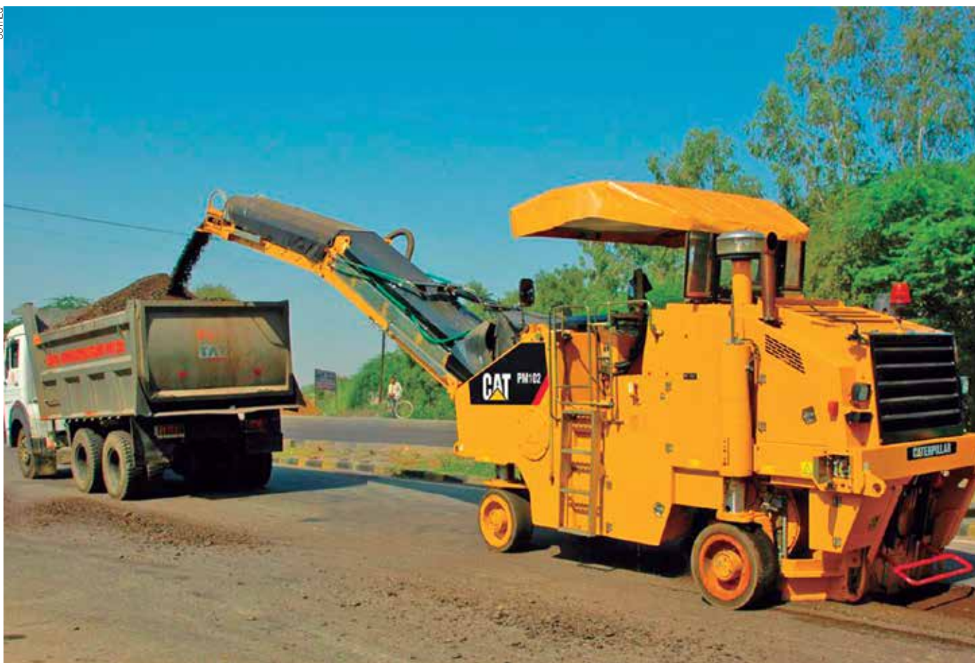
Técnica de restauração depende de avaliações da superfície, dos materiais e do grau de deterioração do pavimento
