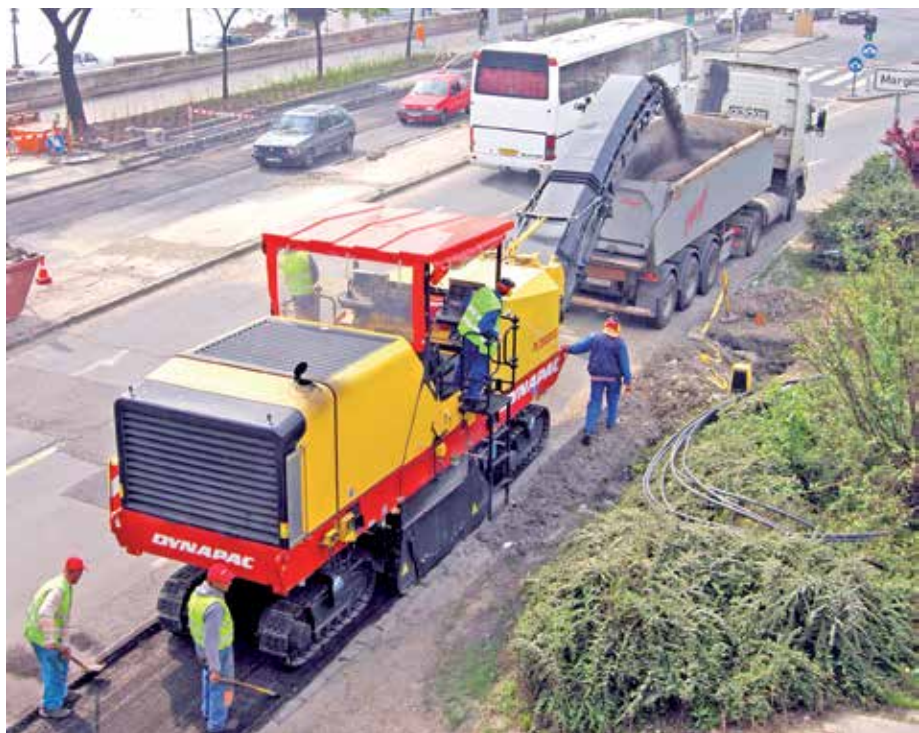
Recuperação de ruas e calçadas é um dos exemplos de serviços essenciais realizados via mecanização
