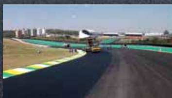
Autódromo de Interlagos SMA com ASFALTO POLÍMERO (NTA FLEX 60/85)
