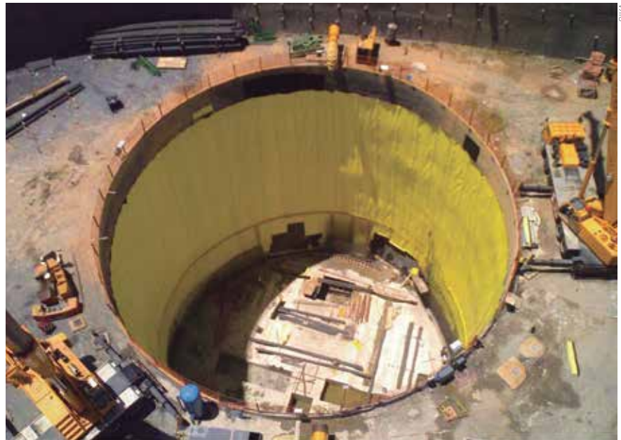
Técnica de impermeabilização evita desagregação em Caracas
