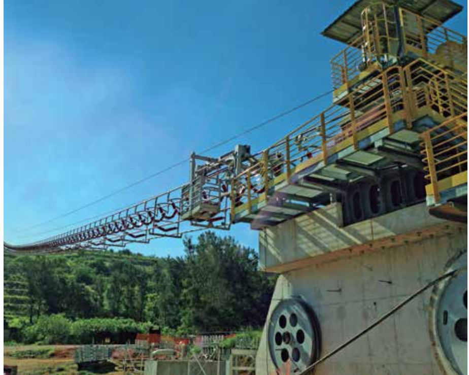
Tecnologia integra correias convencionais com sistema de teleféricos para transportar 1,5 mil t de calcário por hora
