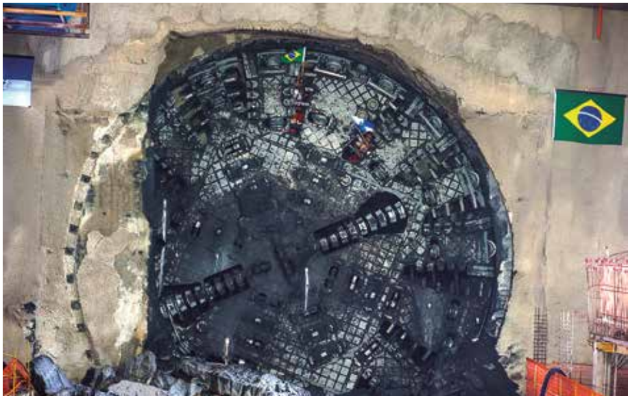
Chegada do tatuzão na Estação Nossa Senhora da Paz: façanha técnica
