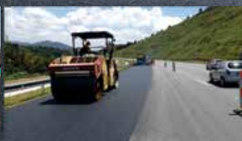
5ª faixa da Rod. Bandeirantes GAP GRADED com ASFALTO BORRACHA (ECO NTAFLEX B)
