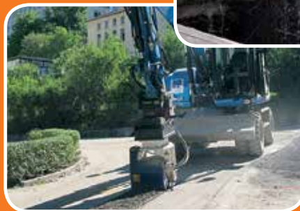
Fresagem de asfalto
