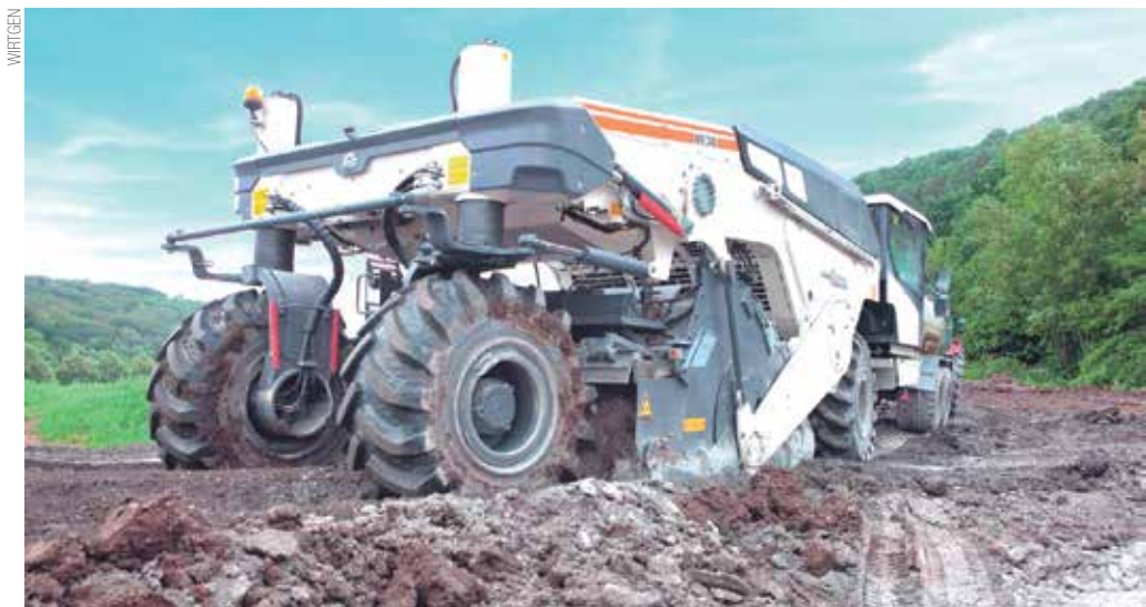
Uso de recicladoras e estabilizadoras gera misturas com maior capacidade de carga para bases e sub-bases
