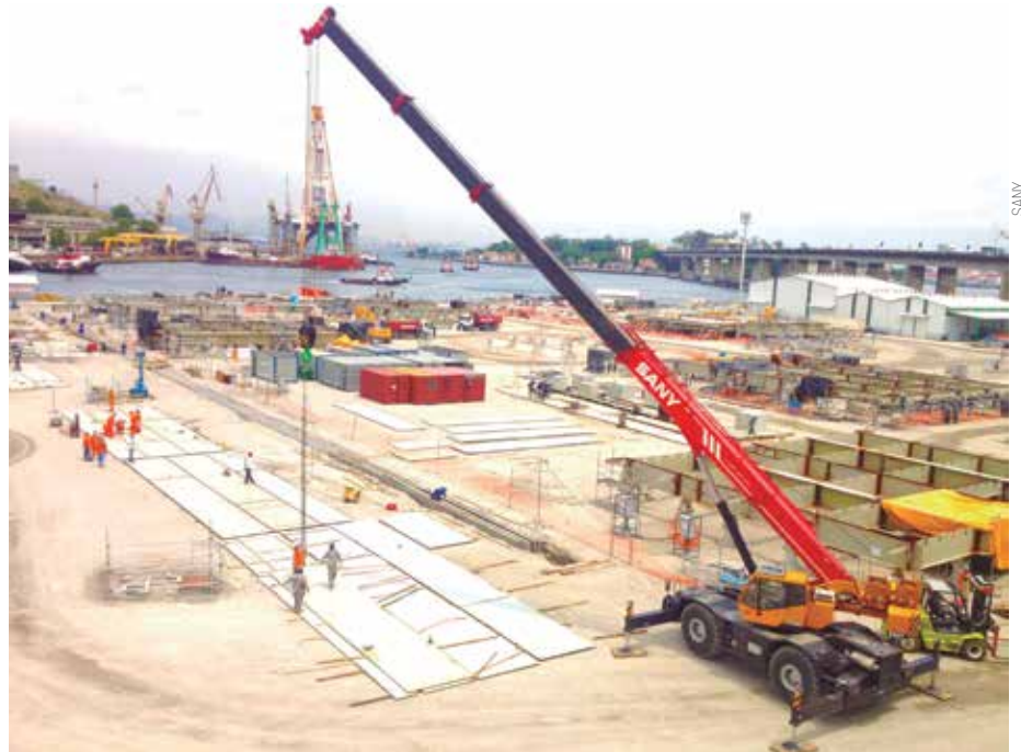
Guindastes RT ganham espaço em operações de içamento de pré-moldados
