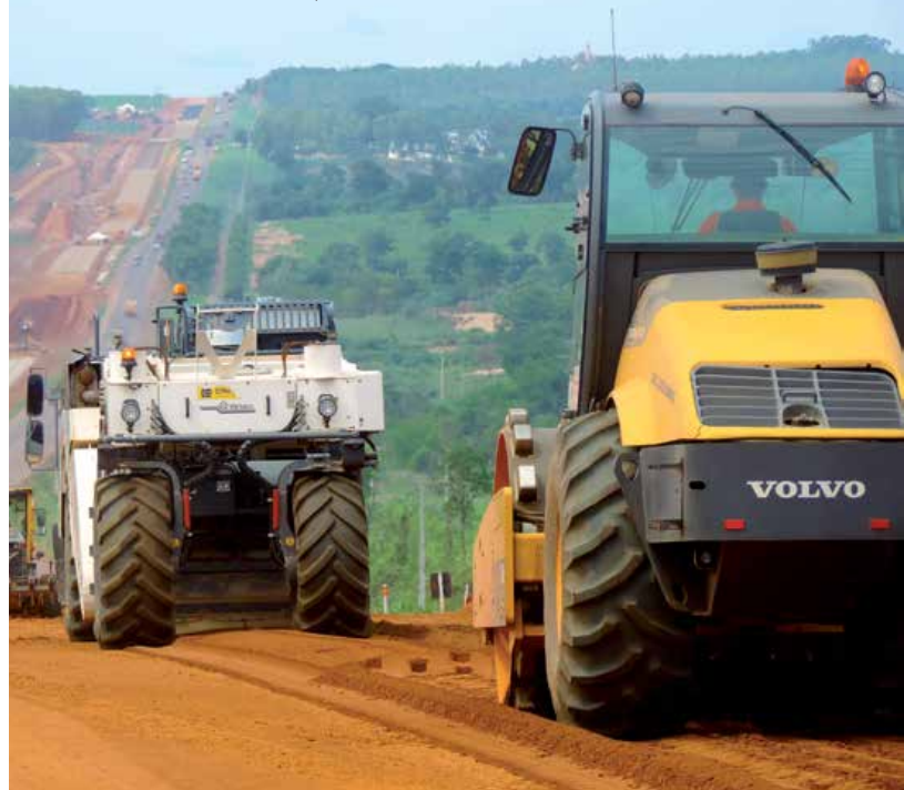
Uso de recicladora soluciona impasse técnico na obra
