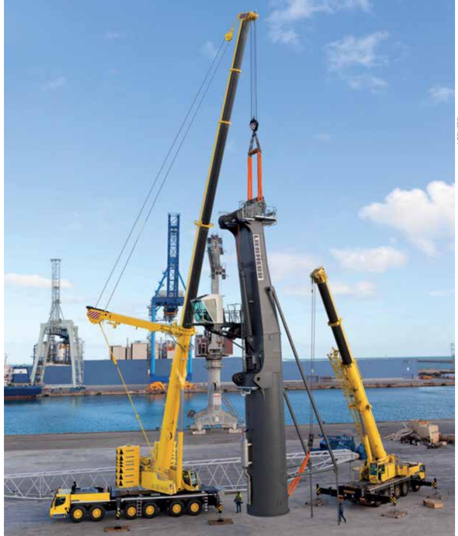
Dificuldade de recuperação limita vida útil de cabos utilizados em equipamentos como guindastes
