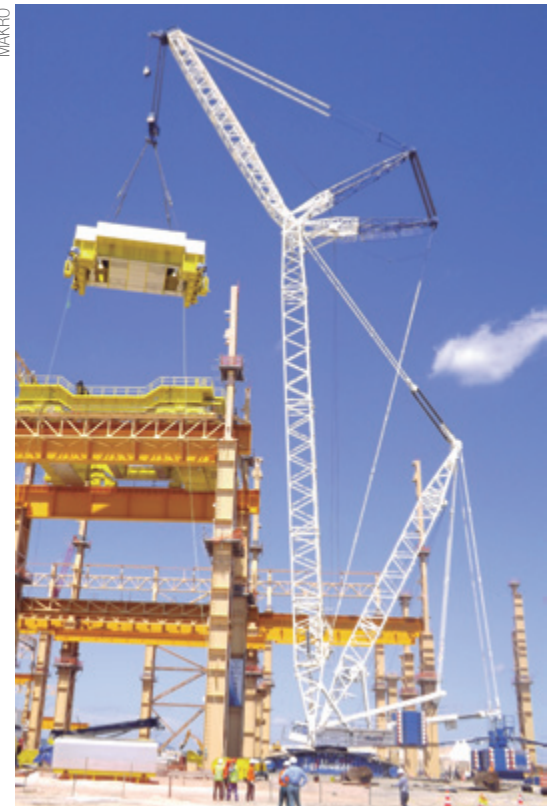
Guindastes não são brinquedos gigantes
