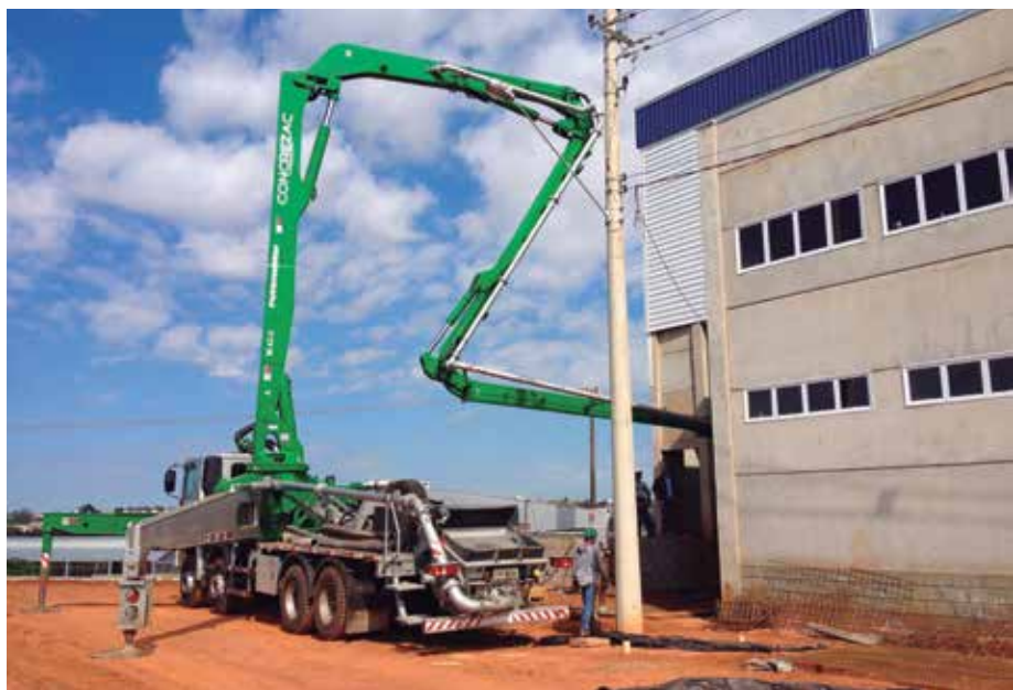
Lança com formato em “Z” ganha espaço na concretagem
