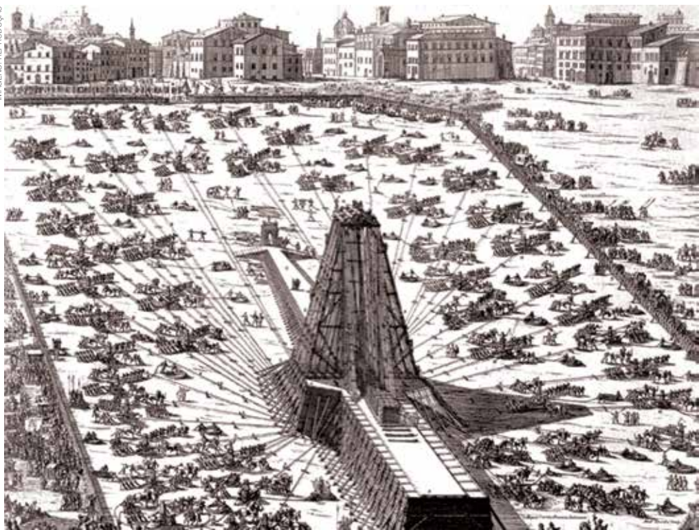
Ilustração mostra construção de obelisco na Idade Média: tração humana
