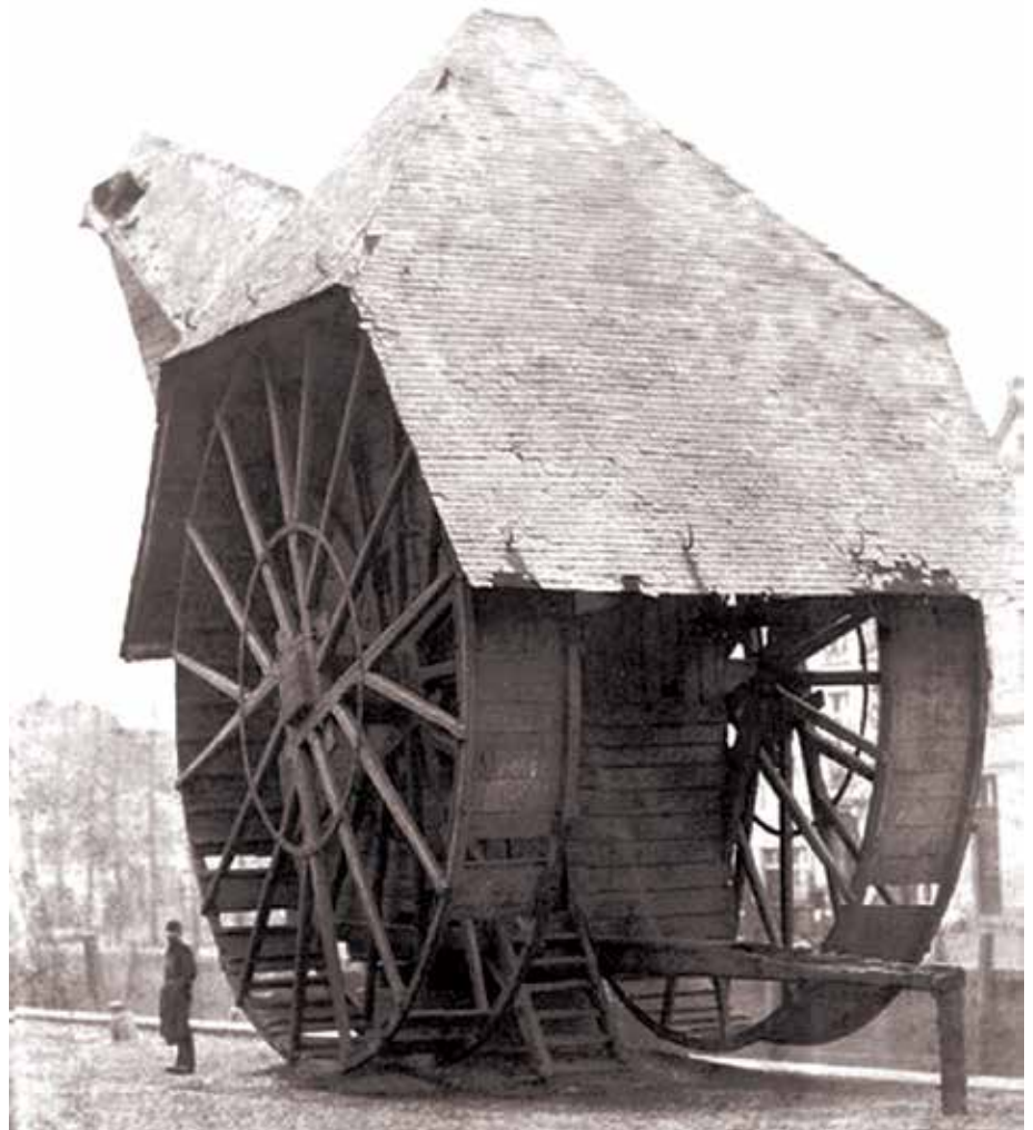
Imagem do séc. XIX registra estrutura da roda de passo: multiplicação da força
