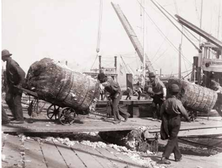
Desembarque em porto no séc. XIX, com cabos de guindastes sem motor ao fundo
