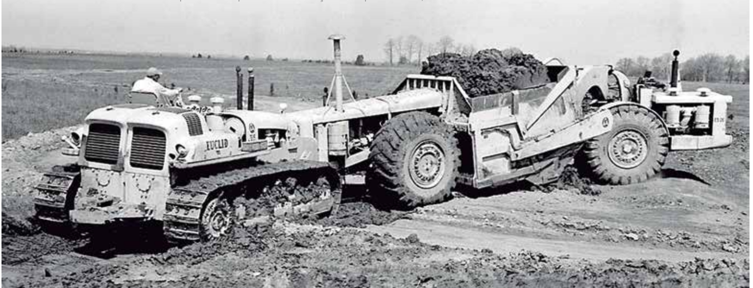
Trator Euclid modelo TC-12 fazendo pusher em scraper TS-24 na construção do aeroporto de Dulles, em 1959
