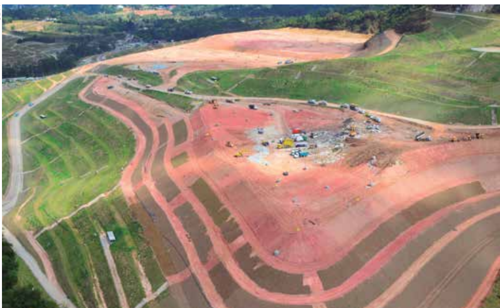
Vista aérea da CDR Pedreira, aterro sanitário privado em São Paulo
