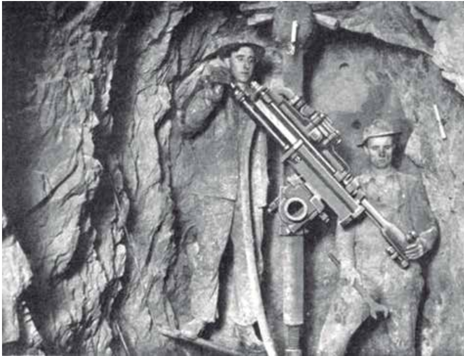
Perfuratriz Holman de 3 ¼ polegadas utilizada nas minas da McKinley Darragh Savage, no Canadá, em 1911
