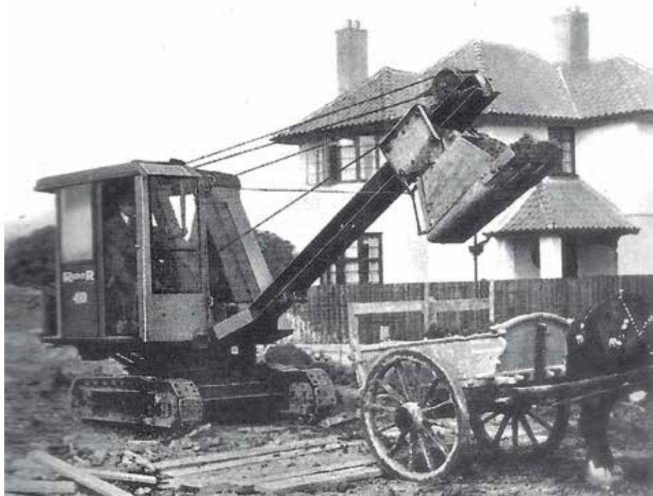
O modelo 410 de escavadeira Rapier pesava apenas 7,4 ton e já era equipado com embreagem hidráulica
