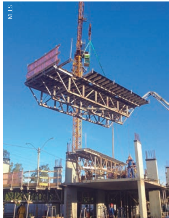
Aplicação deve ser prevista já na concepção do projeto da obra
