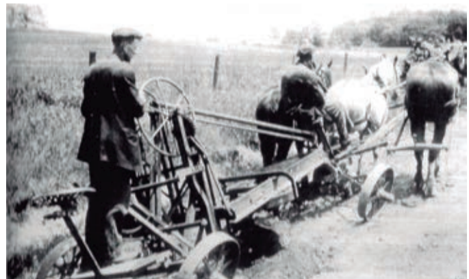
No final do séc. XIX, niveladoras puxadas por cavalos foram as máquinas mais comuns na construção. Na imagem, um modelo Adams com sistema de rodas inclinadas
