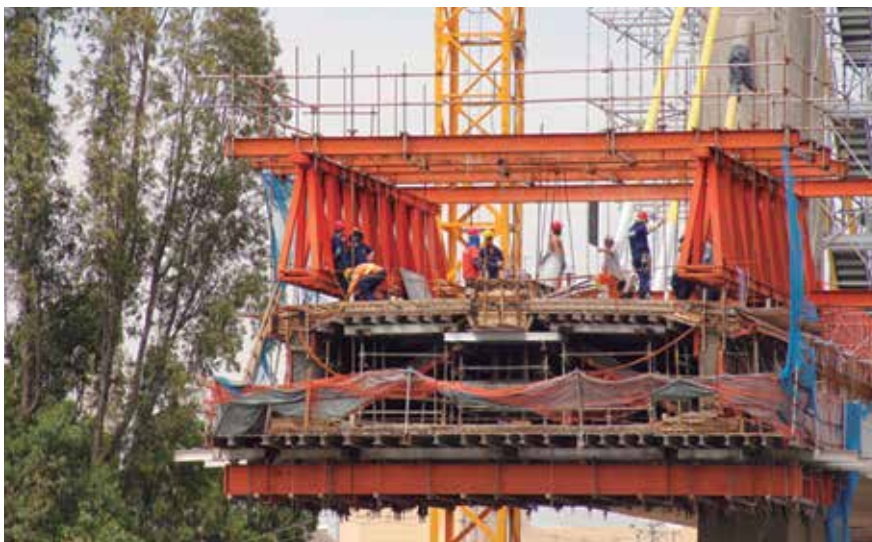
Construção da obra evolui em ritmo de linha de montagem
