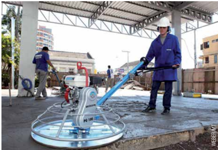
Aplicação das alisadoras de superfície garante obtenção de pisos de alta resistência
