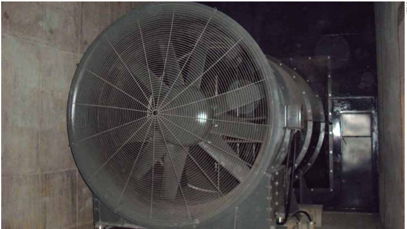
Projetos de túneis rodoviários utilizam com frequência ventilação bidirecional, que contempla reversão do fluxo de veículos
