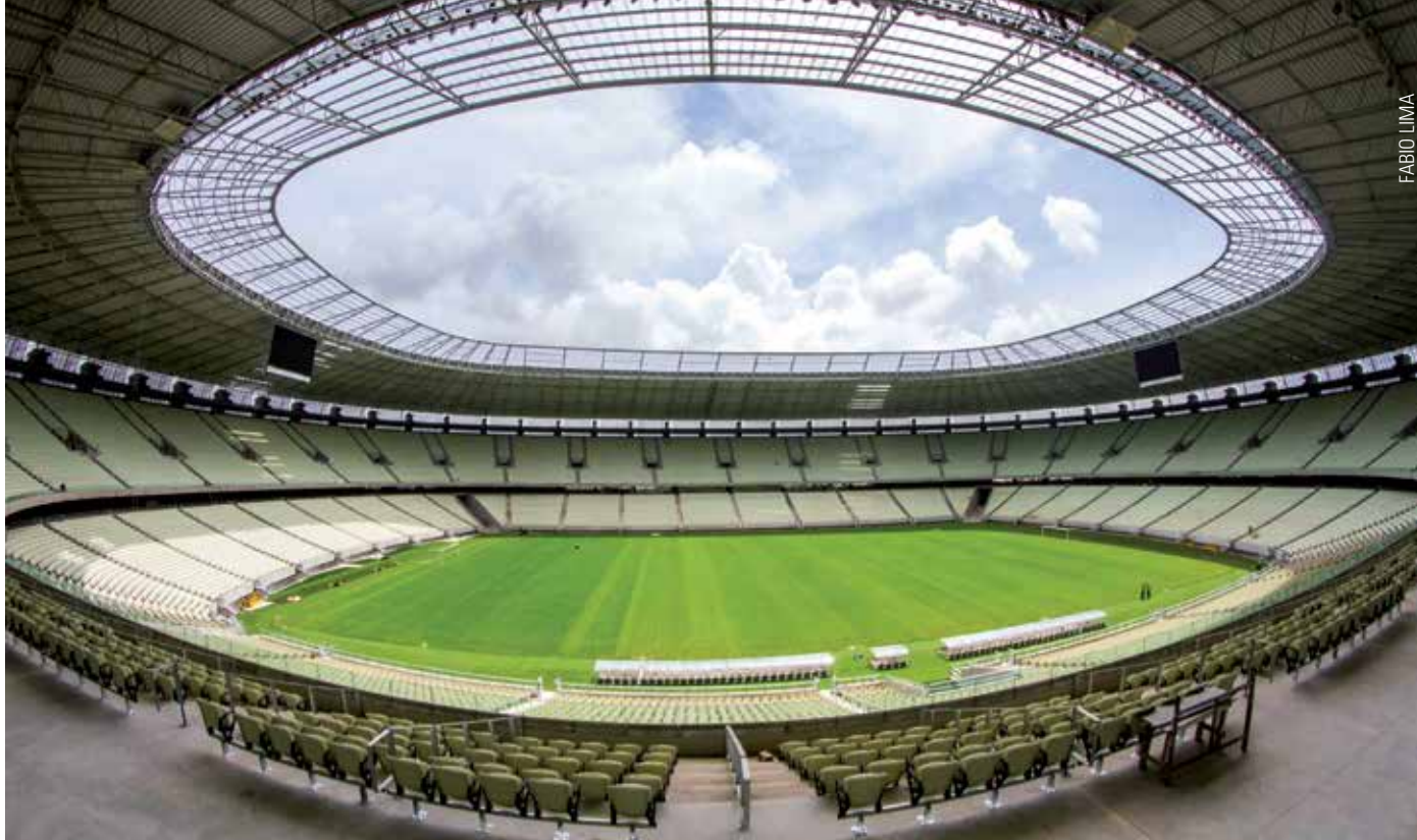
Em Fortaleza, a construção do Castelão incluiu a aplicação de processos industrializados e equipamentos de grande porte
