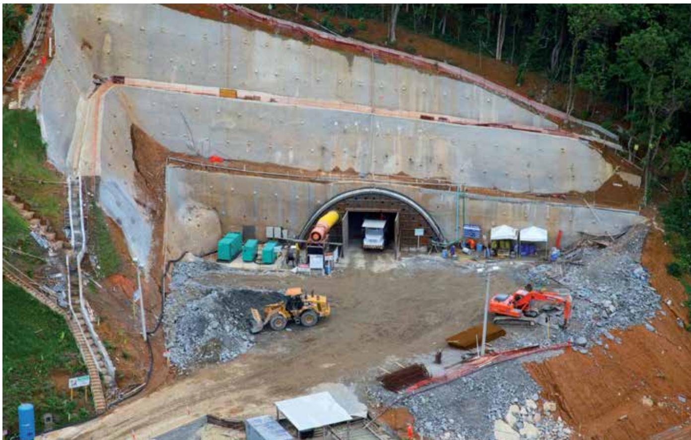
Túnel do Prosub tem 703 m de extensão, com seção de 14,5 m de largura
