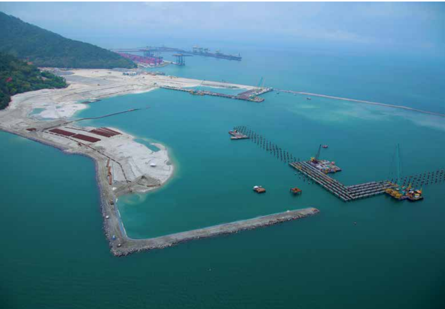
A área sul inclui as obras marítimas do projeto, que exigiram a utilização de dragas de sucção e recalque para retirada de solo e água contaminada
