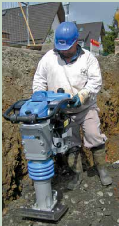
Compactação é a especialidade da empresa
