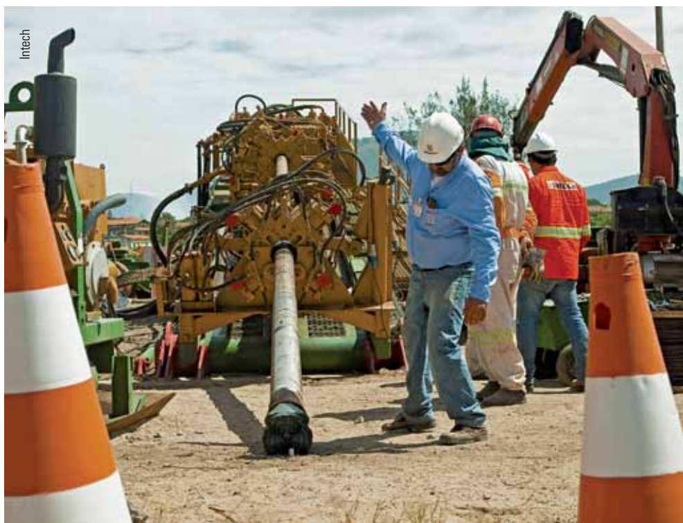
Tecnologia dispensa abertura de valas, não gera resíduos e interfere minimamente no tráfego
