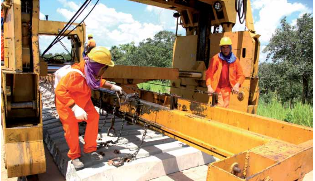
Trabalhando em pares, conjunto mais avançado de pórtico lança até 60 dormentes por ciclo
