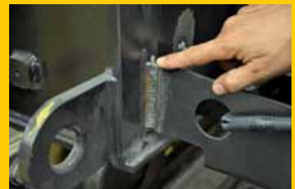
Solda oxidada na estrutura do chassi
