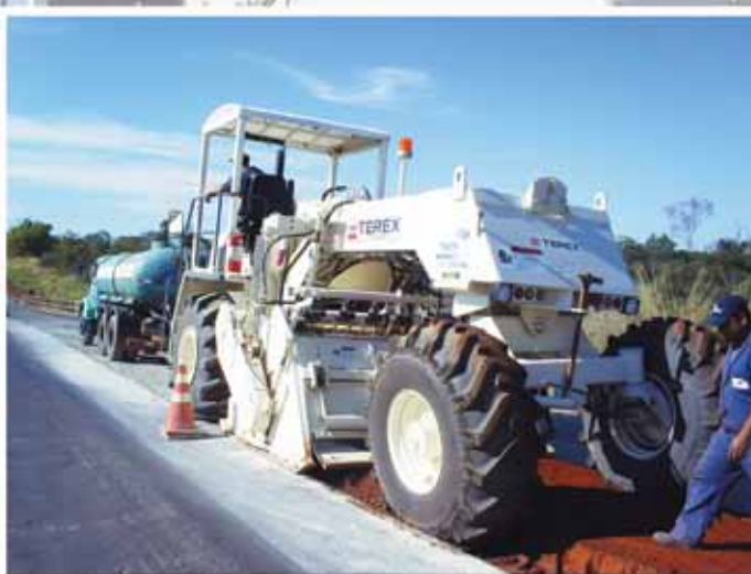
Reciclagem de Pavimento Asfáltico
