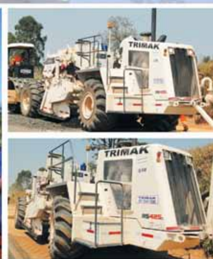
Estabilização de solo
