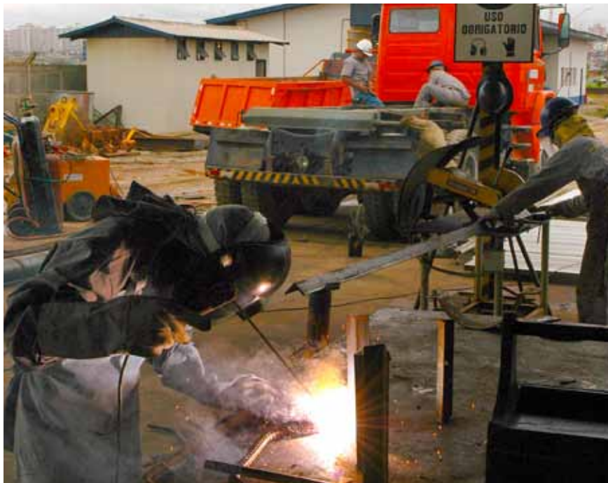
Instalações precisam dispor de área para serviços de solda e caldeiraria
