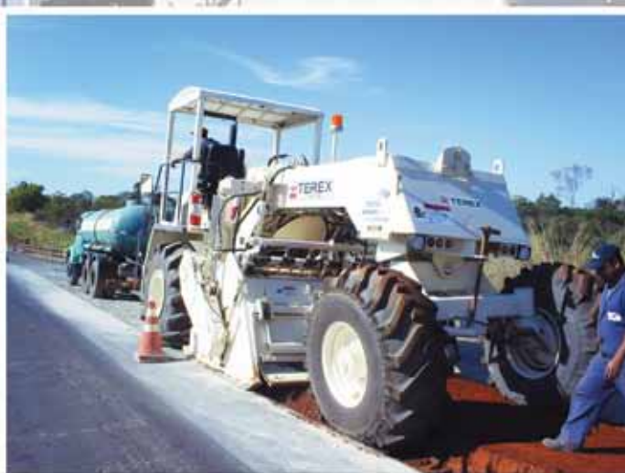
Reciclagem de Pavimento Asfáltico
