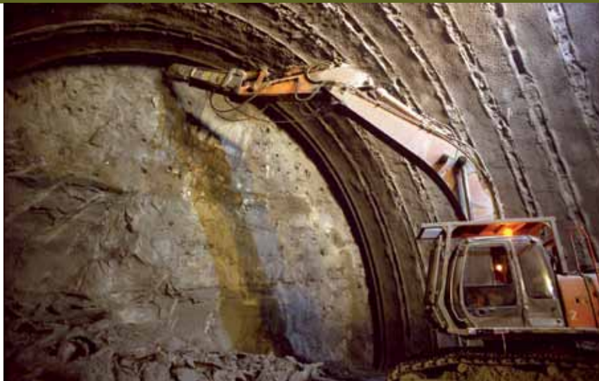
Bate-choco realizado por rompedor hidráulico
