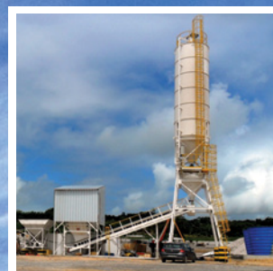
Obras da nova arena Pernambuco
