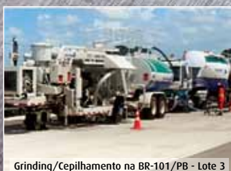
Grinding/Cepilhamento na BR-101/PB - Lote 3
