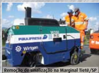
Remoção de sinalização na Marginal Tietê/SP
