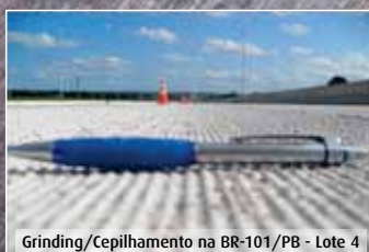
Grinding/Cepilhamento na BR-101/PB - Lote 4
