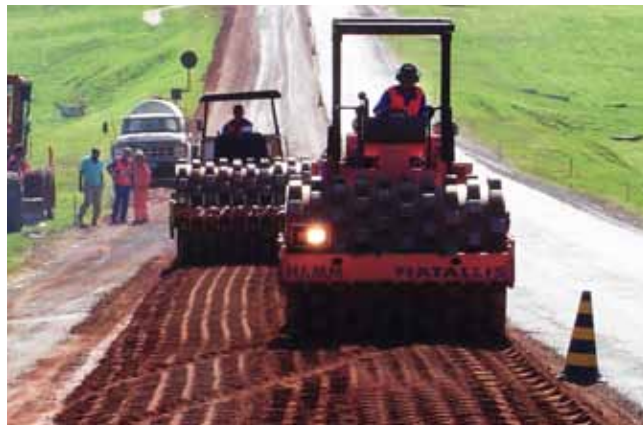
Obras de rodovias: muitos projetos ainda na gaveta
