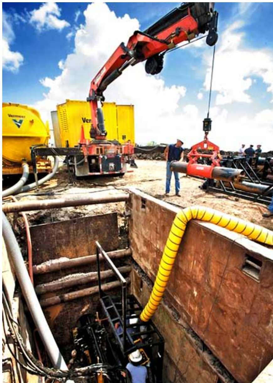
Sistema guiado a laser da Vermeer: substitui o minishield
