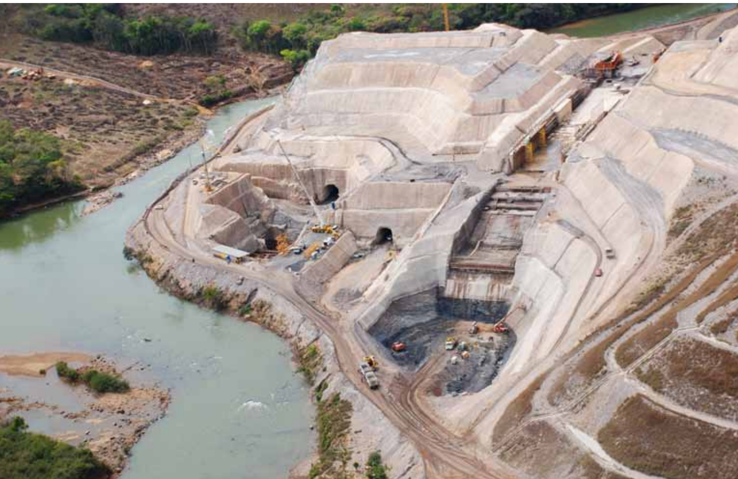
Foto: Grandes Construções
