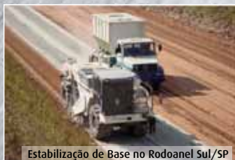
Estabilização de Base no Rodoanel Sul/SP
