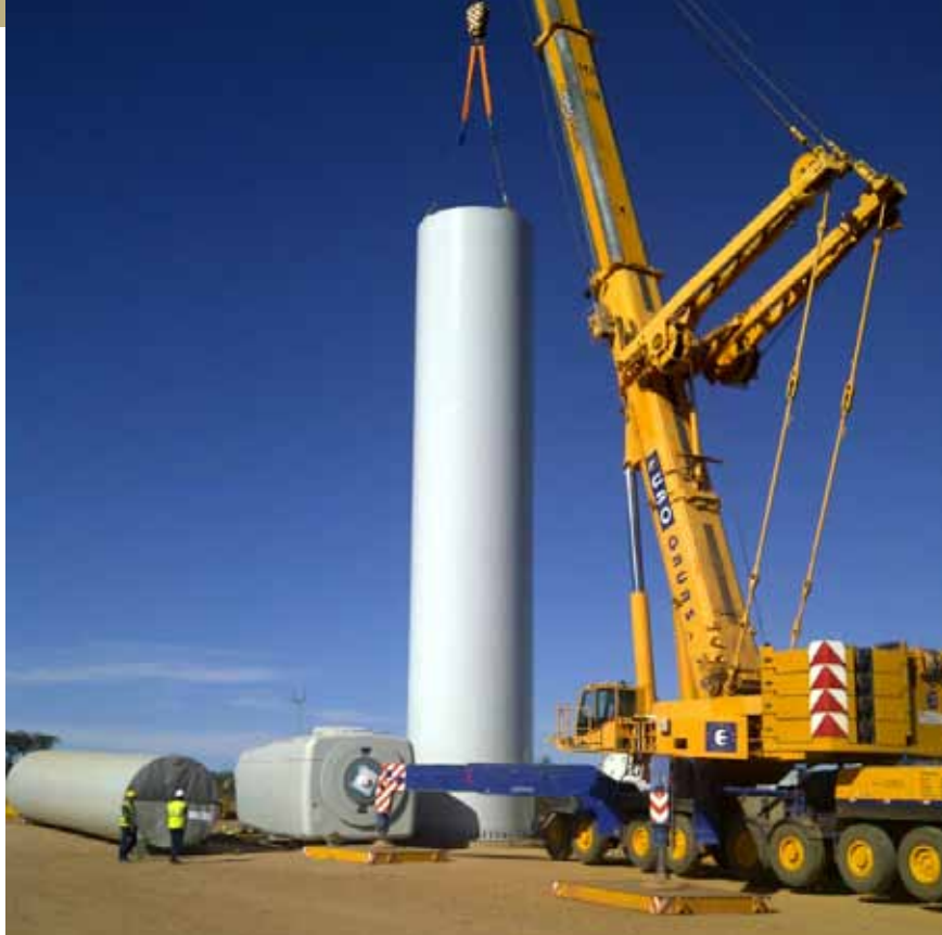
Montagem do equipamento com guindaste AT
