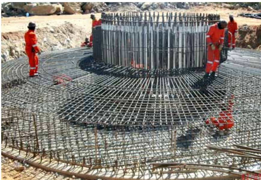
Armação para concretagem dos blocos de fundação
