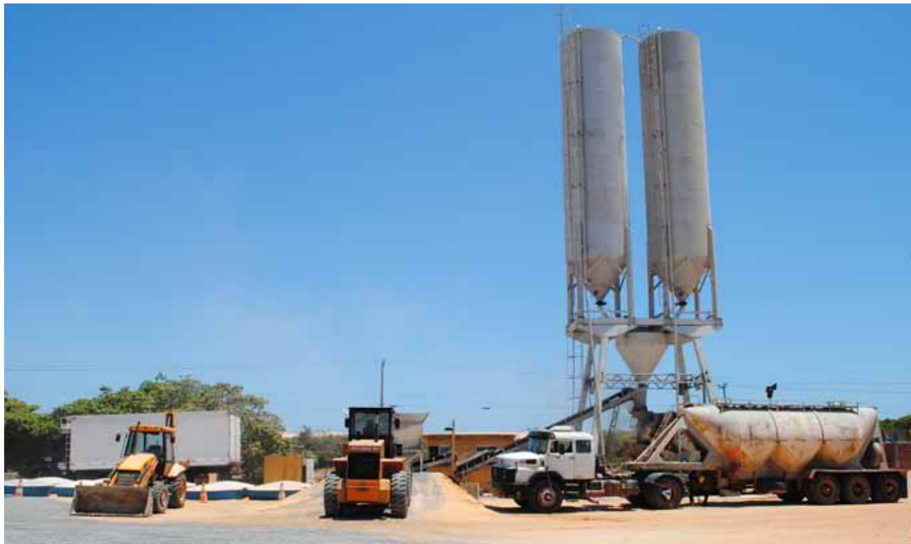
Centrais misturadoras de concreto equipam obras do parque eólico
