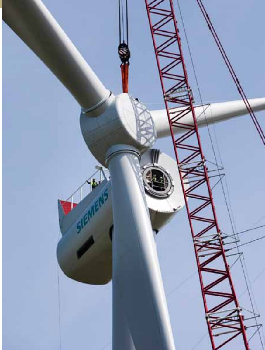
Guindastes de grande porte otimizam a montagem dos equipamentos
