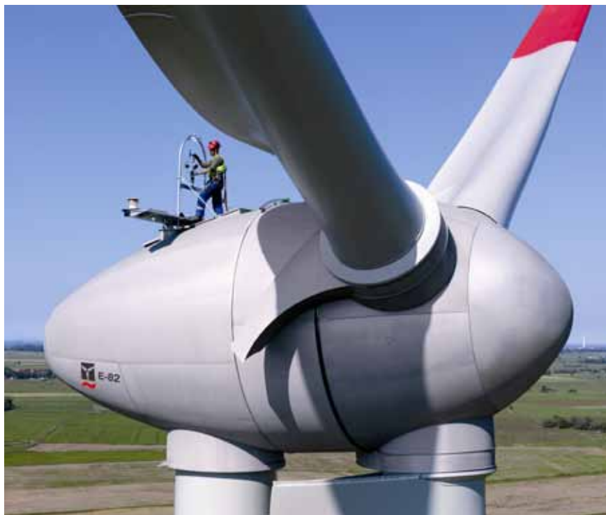
Montagem de torre eólica da Wobben, no Ceará
