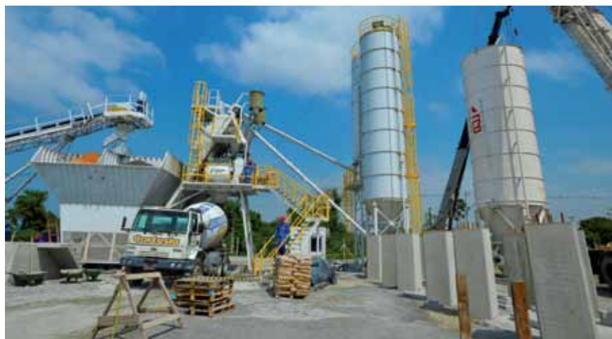
Central de concreto da obra
