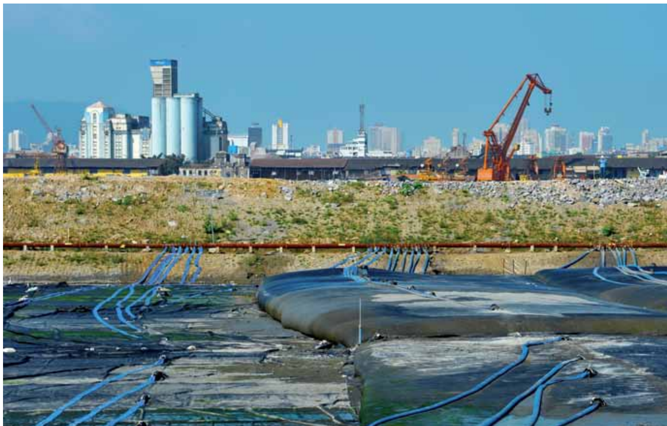
Geotubes armazenam dejetos dragados do canal
