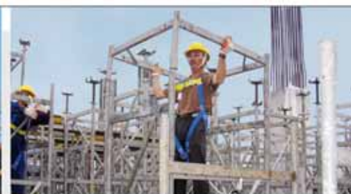
Torres de carga ST 100 Todos os componentes do sistema ST 100 são simplesmente encaixados, sem necessidade de porcas ou pinos.
