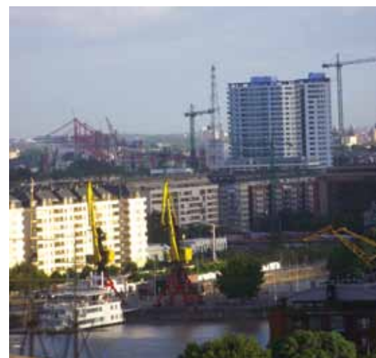
Obras em Buenos Aires, Argentina
