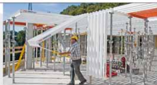
Formas para lajes GRIDFLEX é o mais completo sistema modulado para lajes.
