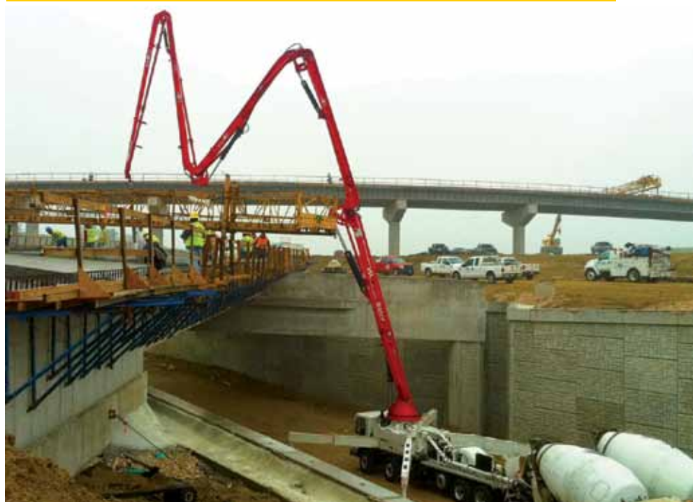
Lança em Z: flexibilidade para as concretagens
