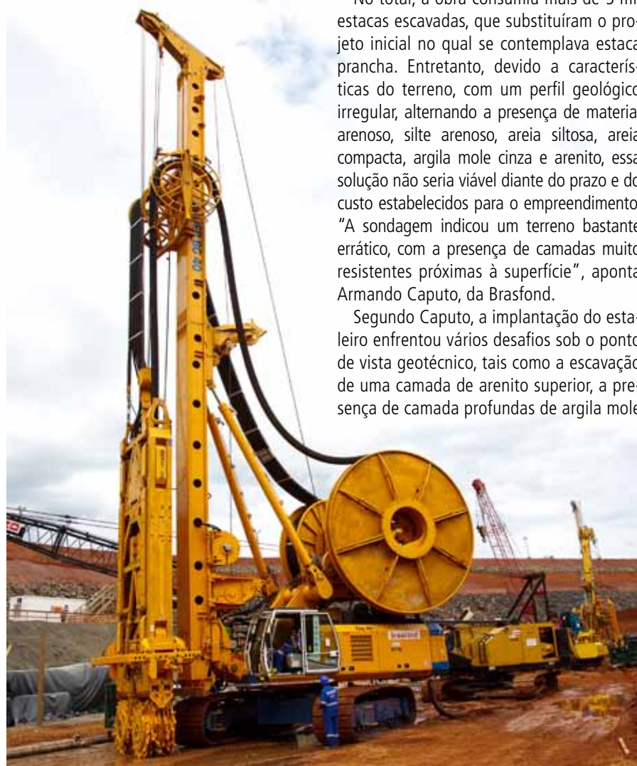
Tecnologia Hidrofresa: escava rocha de até 100 MPa
