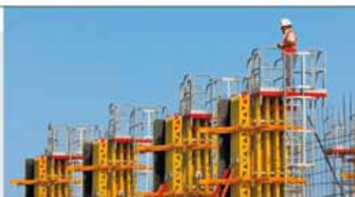
Formas para colunas O sistema VARIO GT 24 é muito versátil e pode ser aplicado em diferentes tipos de obra.
