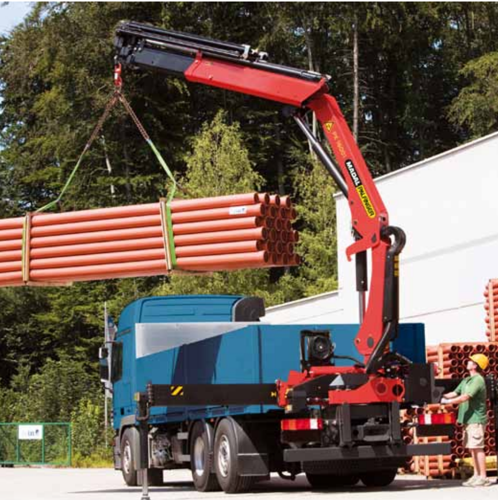
Guindaste operado por controle remoto: maior segurança
