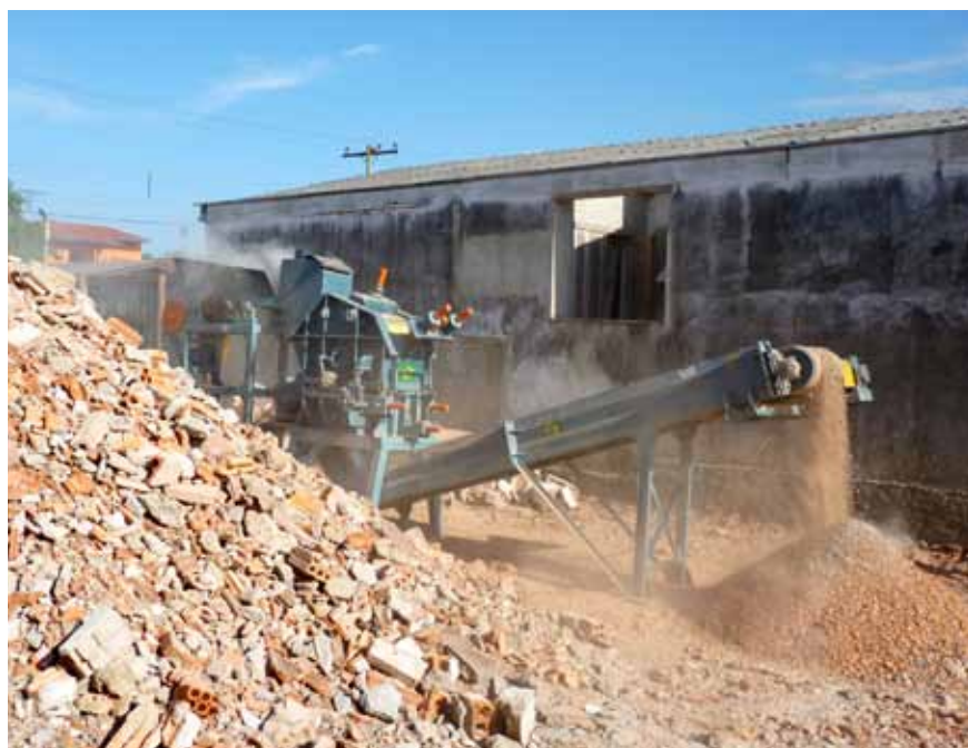
Nas grandes obras (abaixo), a reciclagem (acima) pode produzir material para aplicações estruturais
