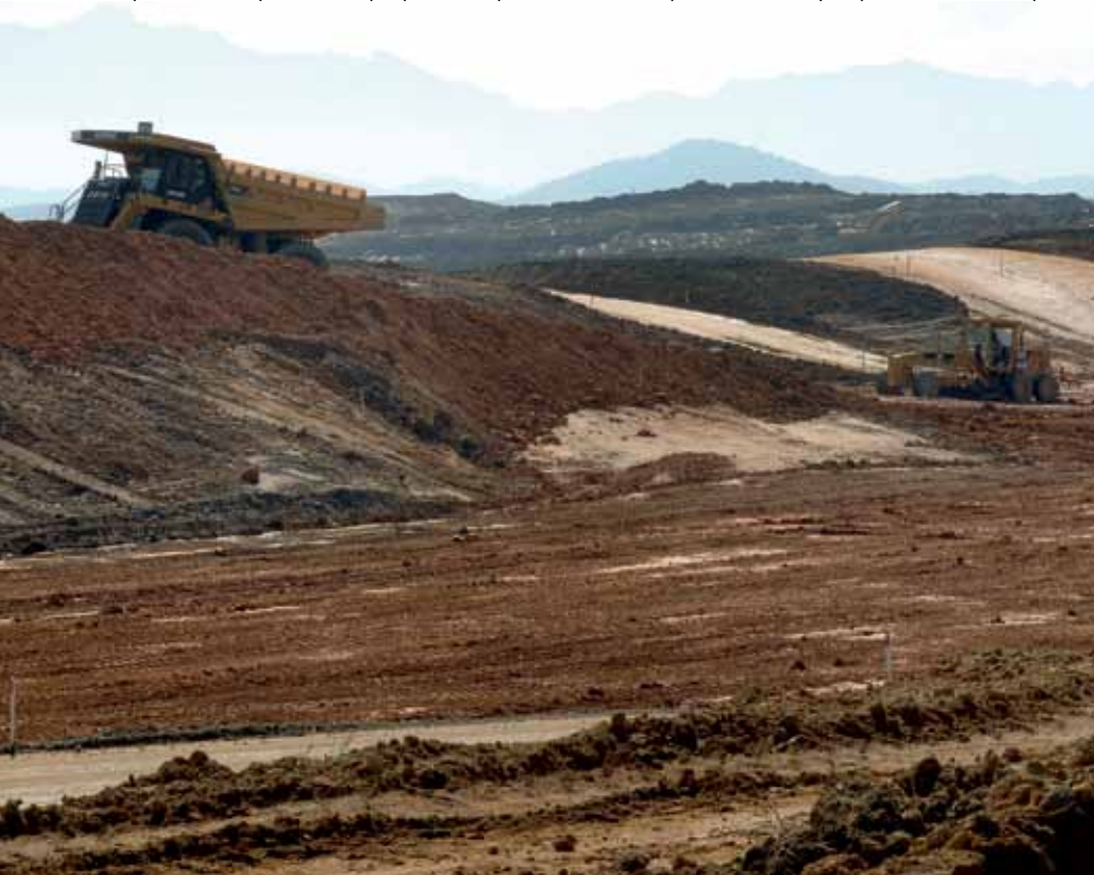
Terraplenagem mobiliza muitos caminhões fora-de-estrada
