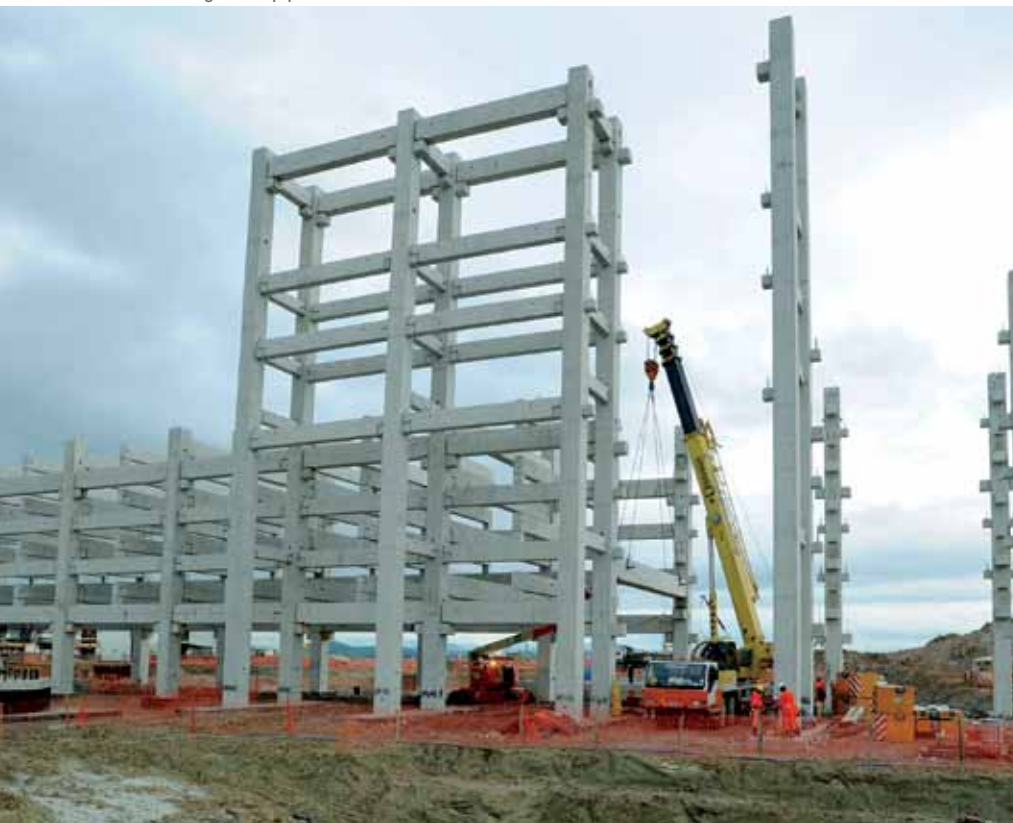
Montagem do pipe-rack da UDAV
