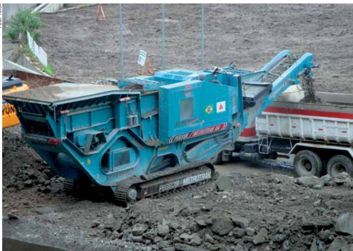
Reforma do Estádio Mineirão (BH): descarga do material britado diretamente nos caminhões
