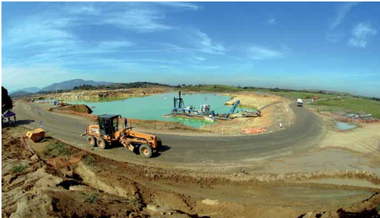
Rebaixamento de lençóis freáticos envolveu serviços de drenagem profunda
