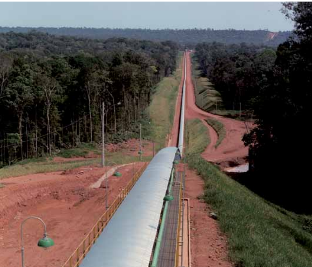
Correia transportadora da MRN: com cobertura
