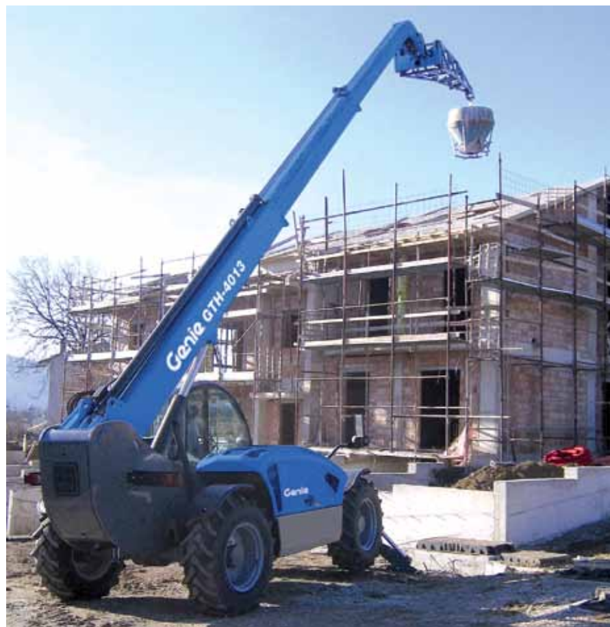
Transporte de concreto: uma das funções do equipamento
