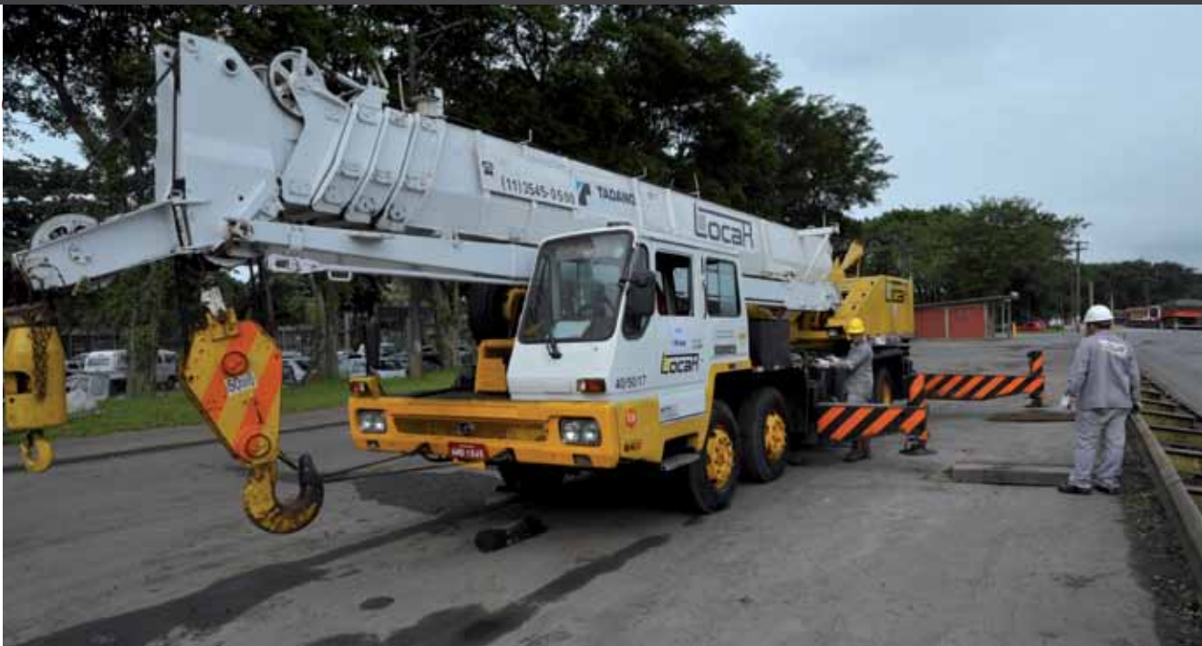
Operador realiza o patolamento do guindaste
