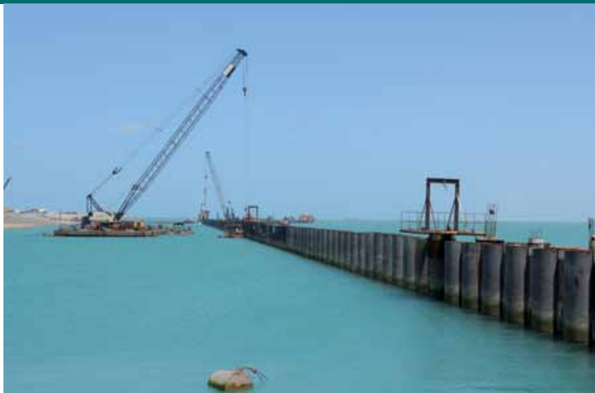
Fundações da ponte de acesso: parede metálica para conter o aterro hidráulico
