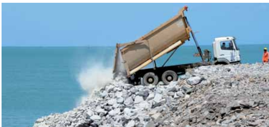
Execução do quebra-mar: logística para a movimentação dos caminhões
