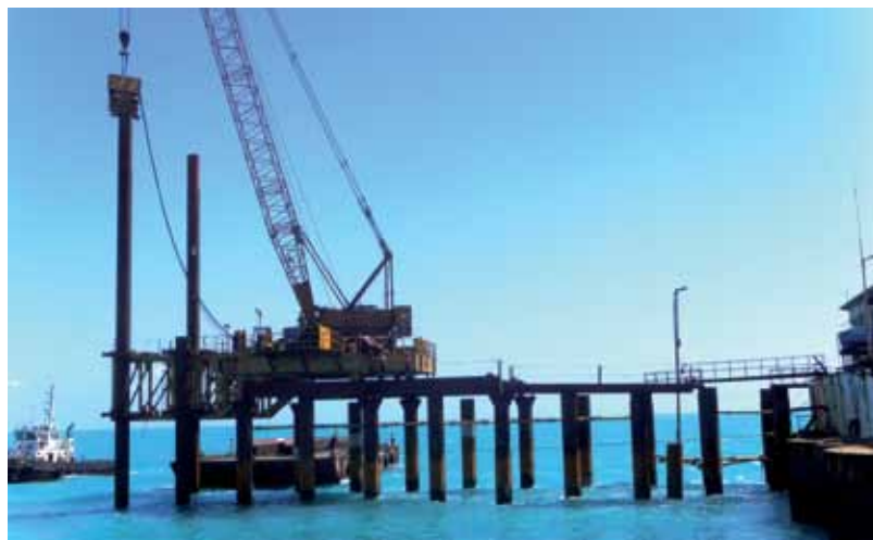
Cravação de estacas: com guindastes de 350t
