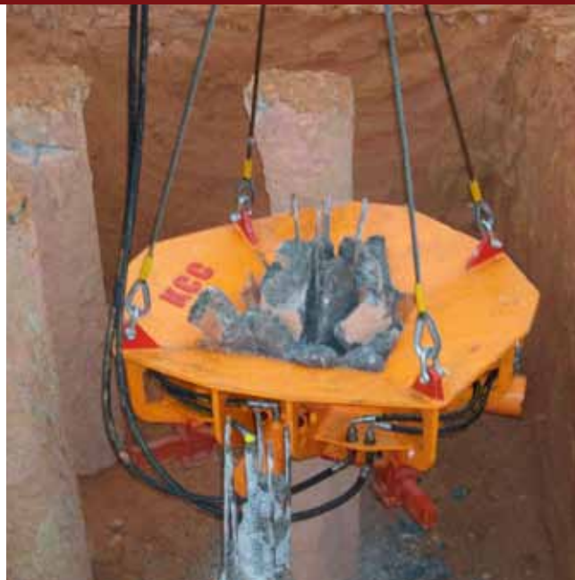
Mesa fixa de arrasamento: para estacas menores
