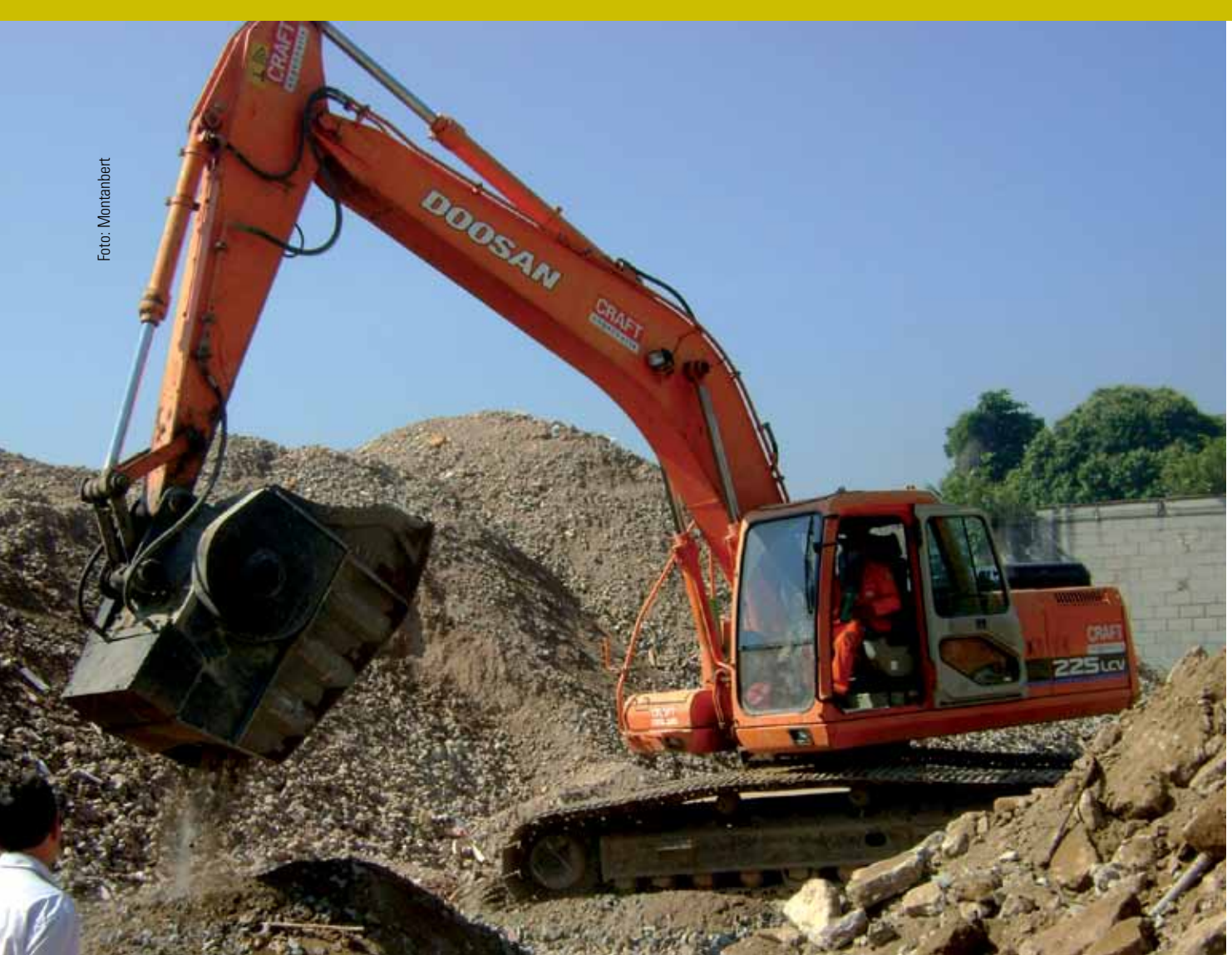
Caçamba britadora opera com sistema de mandíbula
