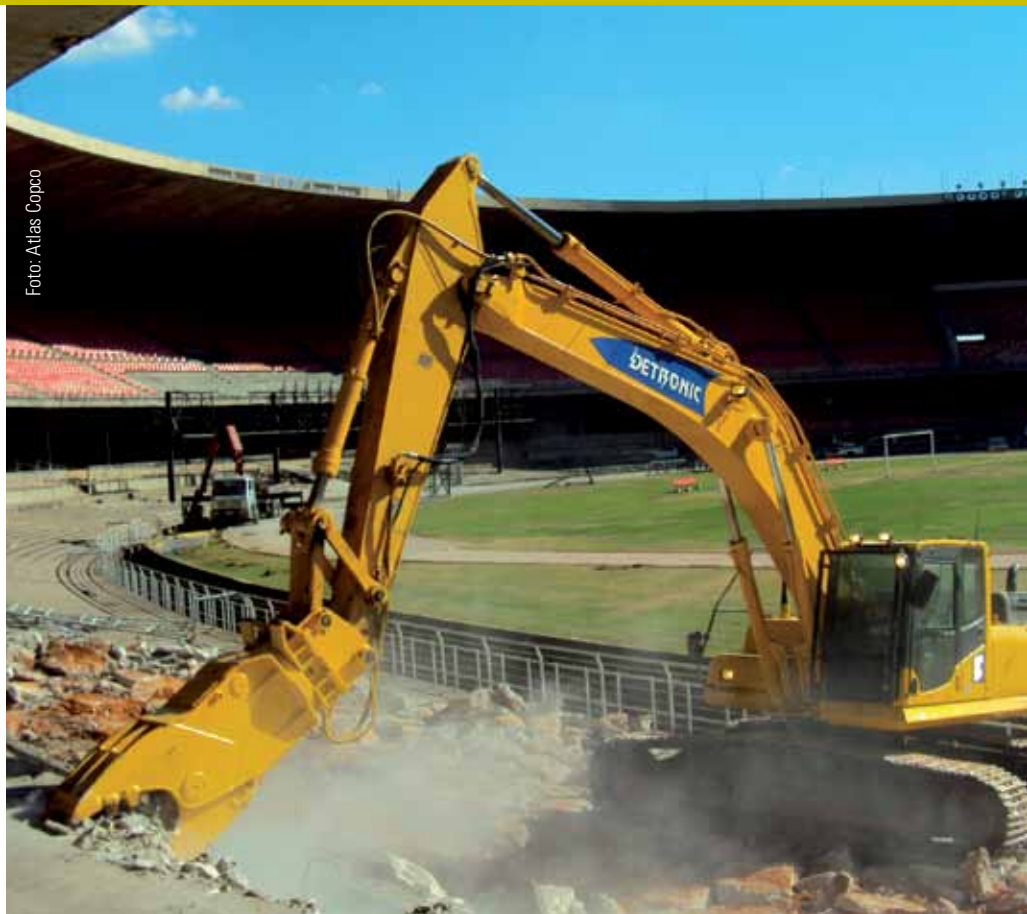
Pulverizador atua na demolição de estádios
