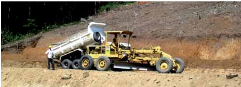
Mobilização de equipamentos na Transoeste
