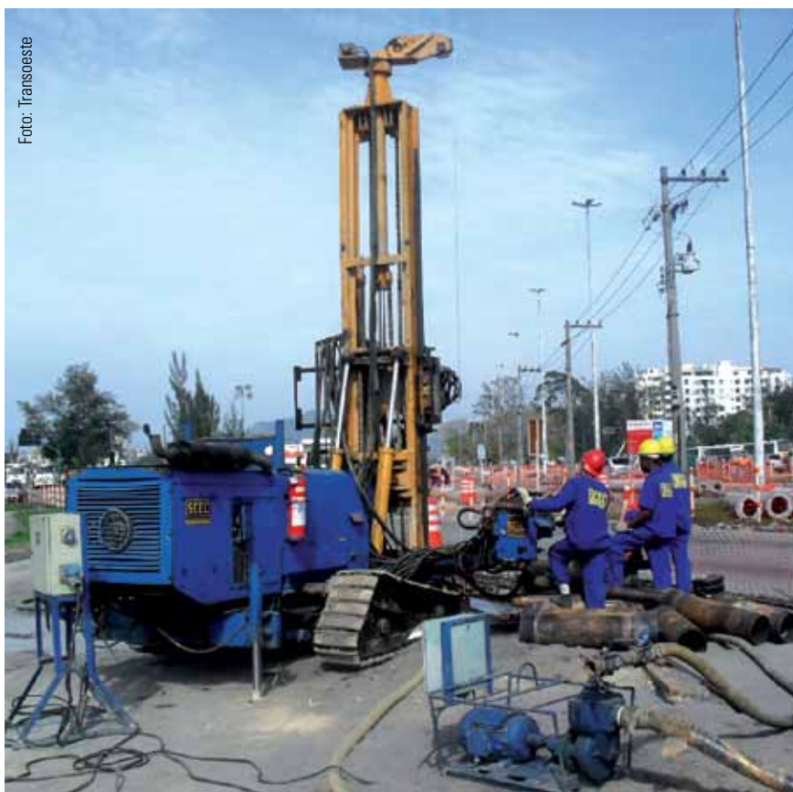
Fundações da Transoeste executadas por bate-estacas
