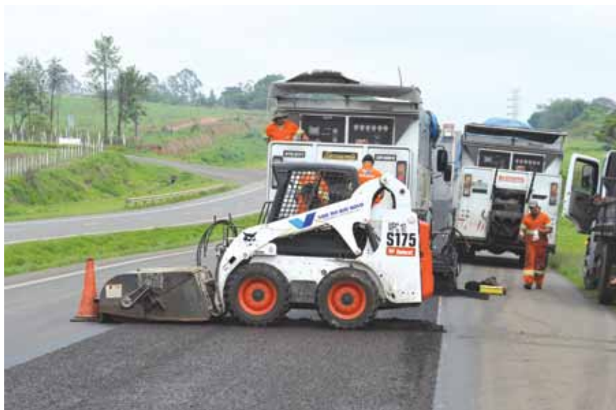
Minicarregadeira com implemento tipo vassoura auxilia microfresagem
