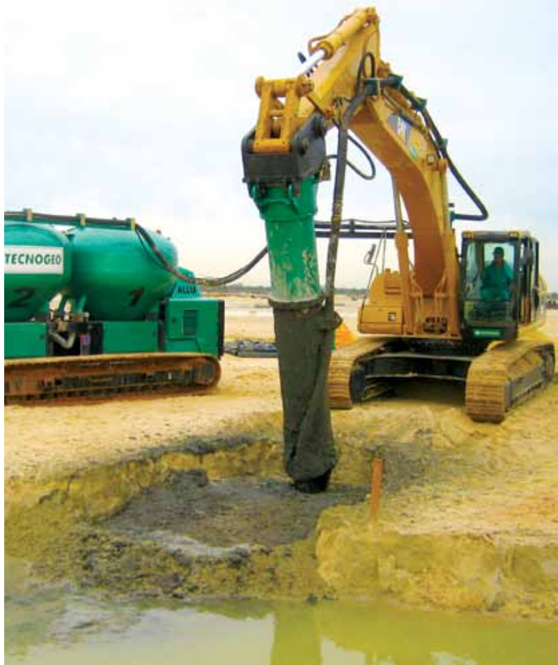
StabTec é utilizado para vencer solos moles
