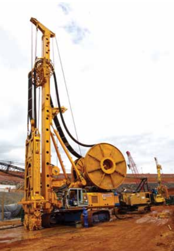
Hidrofresa realiza fundações de até 120 metros
