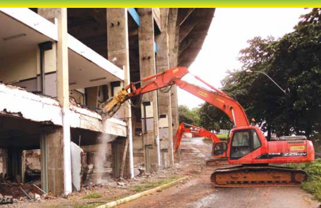
Demolição do Fonte Nova: sustentabilidade e produtividade com a mecanização
