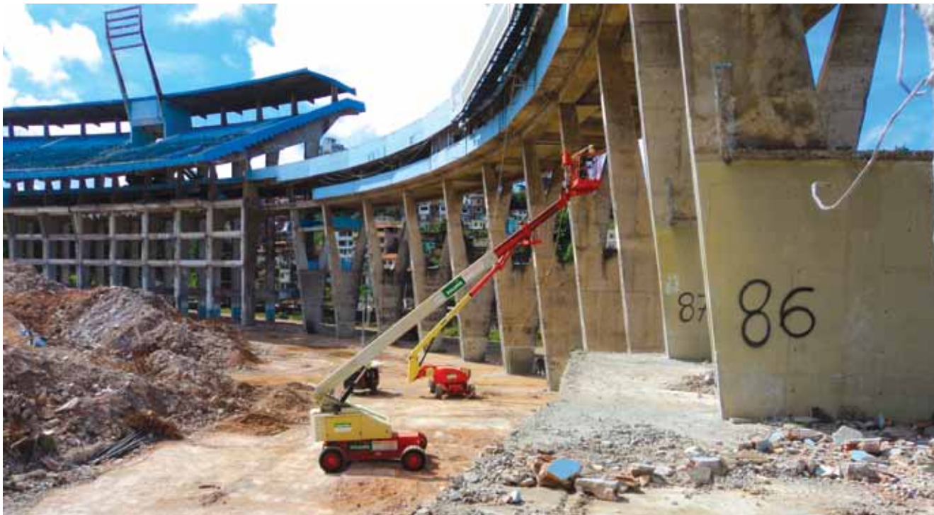
Plataformas aéreas foram utilizadas na instalação dos explosivos
