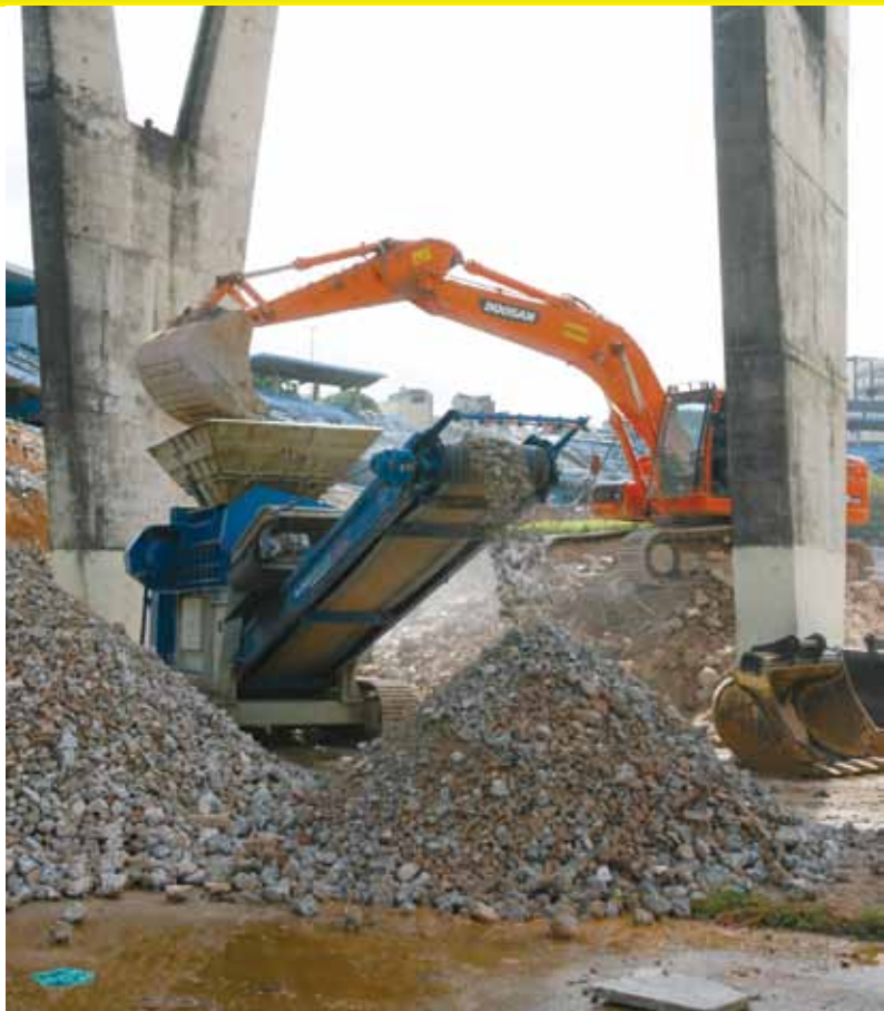
Arena Salvador: 40 mil m 3 de estruturas de concreto serão reaproveitados
