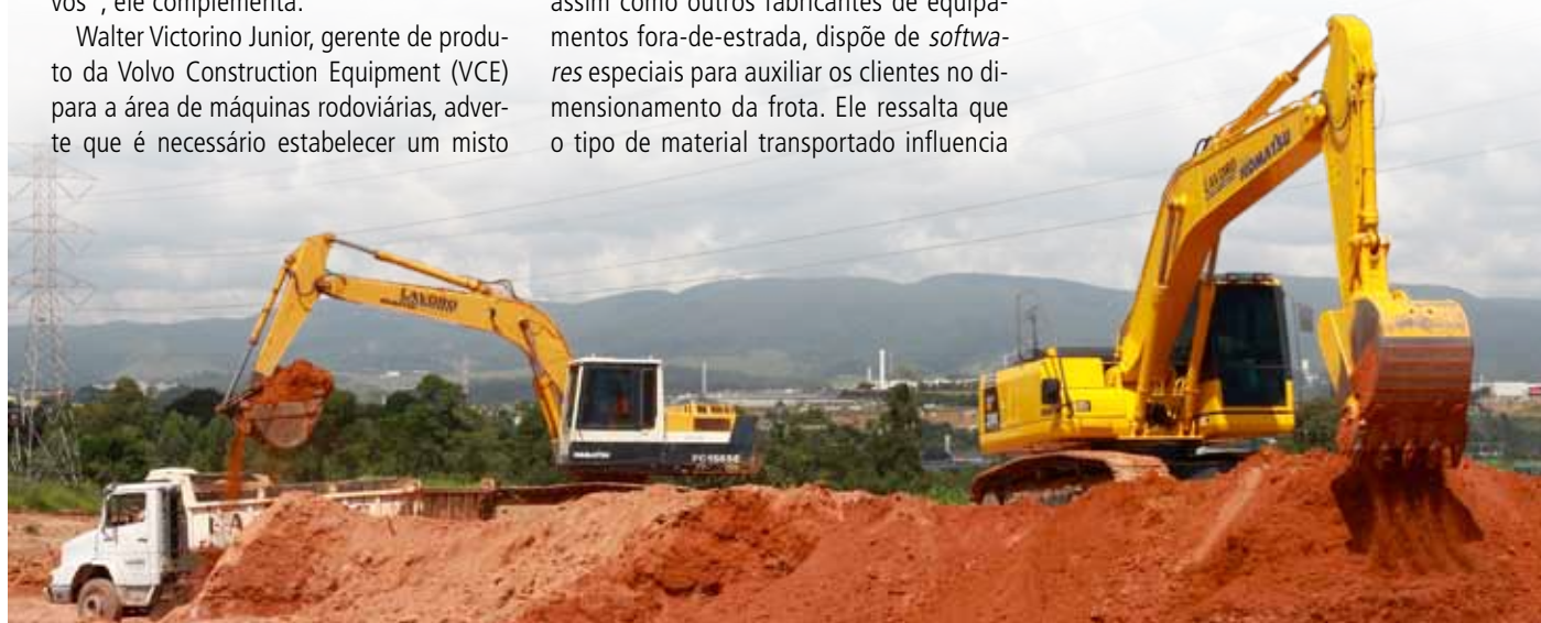
Escavadeiras são mais utilizadas para carregamento nos canteiros
