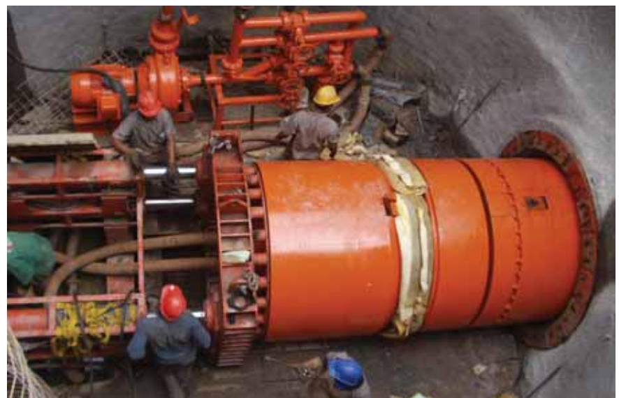
Sistema pipe jacking: tradicional em obras de saneamento
