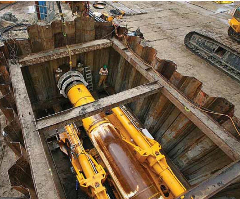
Tecnologia Direct Pipe: alternativa ao pipe jacking com maior velocidade na instalação
