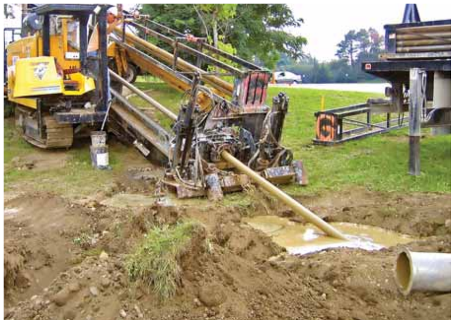
HDD: pouco eficiente para instalar redes de baixa declividade
