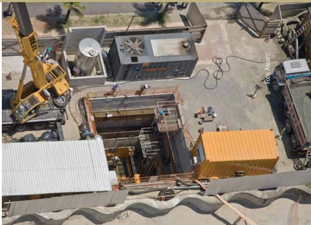
Uso de minishield em rede de saneamento: obra sem impacto na superfície
