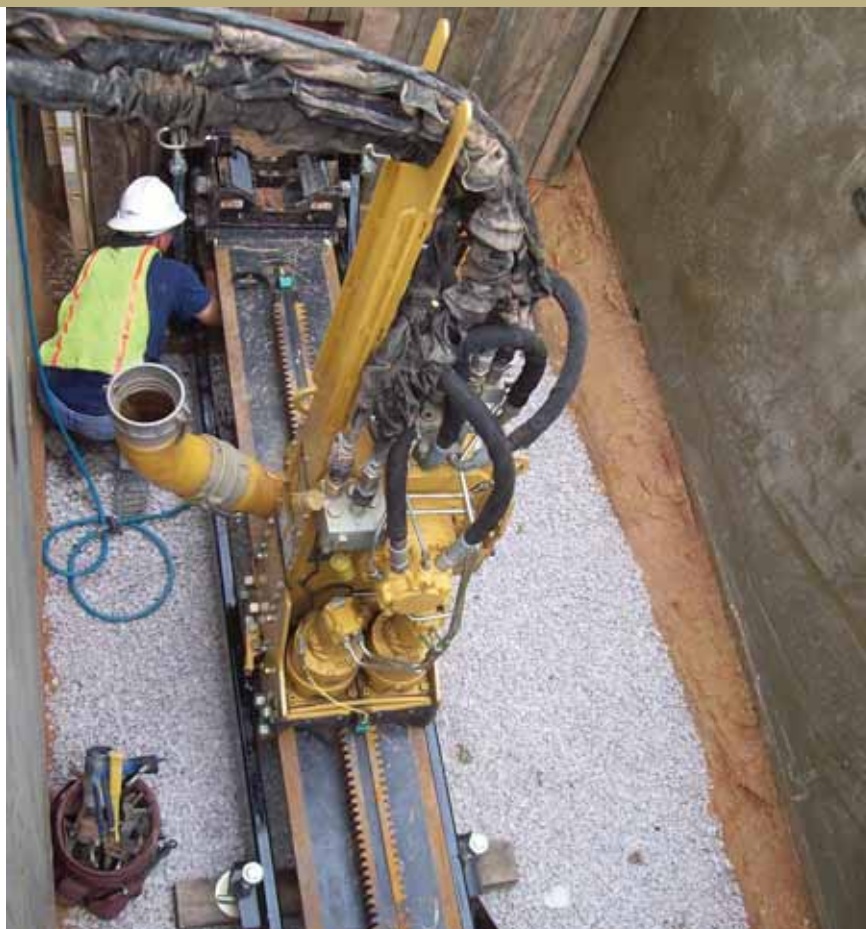
Sistema Axis: perfuração guiada a laser para cravar qualquer tipo de duto
