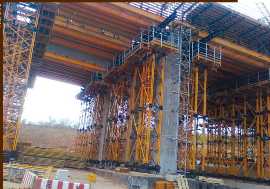
Sistema permite concretar estruturas de formatos variados
