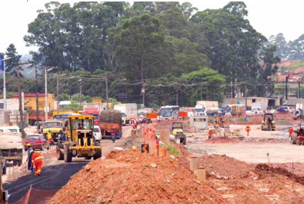
Obra convive lado a lado com tráfego intenso de veículos
